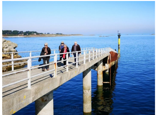
Figure 4 : Extrémité nord de l'estacade / embarcadère à marée basse
